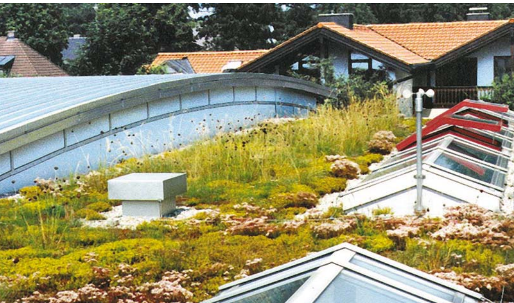
01-02| Příklady skladeb jednovrstevné vegetační střešy s parozábranou, tepelnou izolací a hydroizolací z asfaltových pásů
